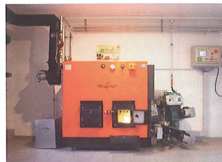
Les chaudières à bois Heizomat HSK-RA délivrent une puissance de 15 à 200 kW.
